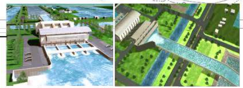
คลองระบายน้ำสุราษฎร์ธานี และสถานีสูบน้ำ 100 ลบ.ม./วินาที
